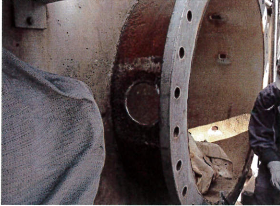
1.素地調整前状況
